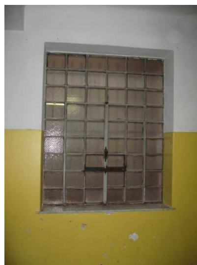
Figura 4.4 – Infisso con telaio in acciaio e vetro singolo zona palestre.
