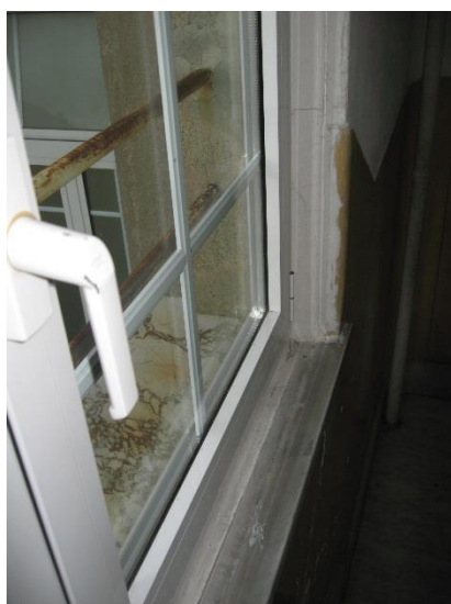
Figura 4.3 - Particolare degli infissi con telaio in alluminio e vetrocamera.
