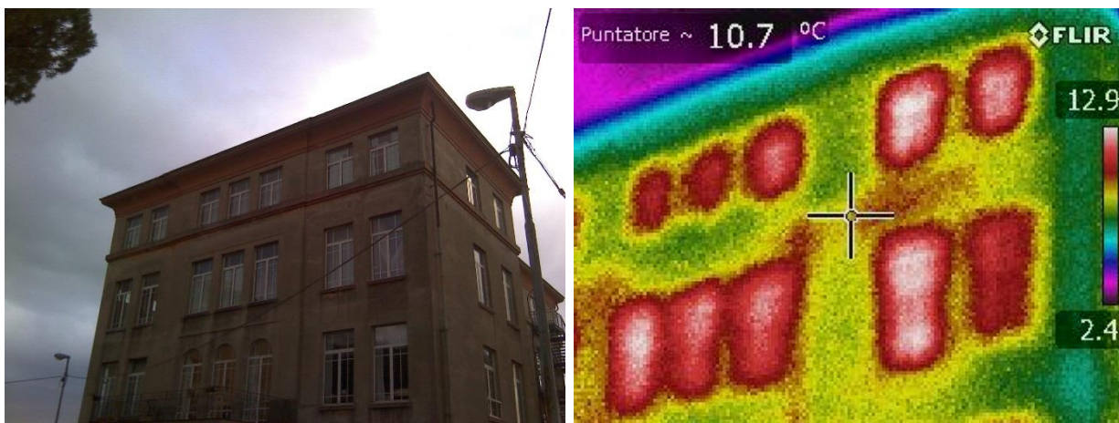
Figura 4.2 – Rilievo termografico della parete esterna Nord-Est
