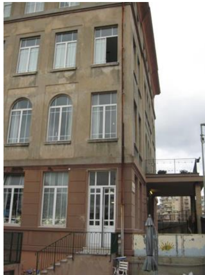
Figura 1.1 - Vista della facciata esposta a Sud-Est
