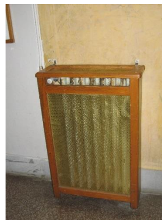
Figura 4.7 - Particolare radiatore in ghisa con protezione
